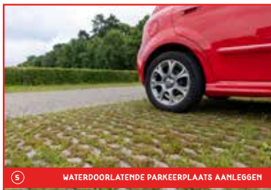
5 WATERDOORLATENDE PARKEERPLAATS AANLEGGEN
